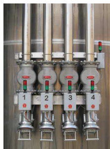
02 Silcontrol Système de détrompage matière
