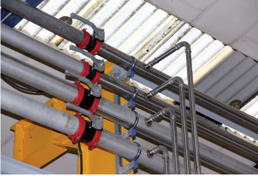
07 Détail tuyauteries inox de distribution
